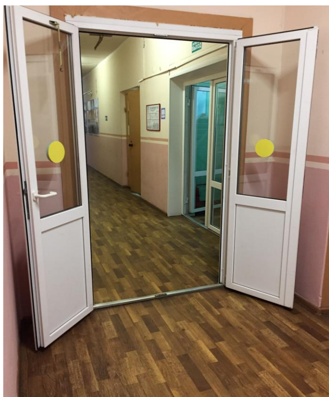
Рис. 4. Обеспечены проходы (проезды) для инвалидов и лиц с ОВЗ с нанесением на стеклянных панелях контрастная маркировка (желтым цветом).
